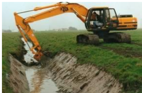
Figure 17 : Exemples de curage et reprofilage de fossé
